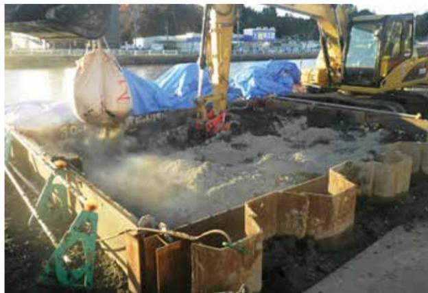
セメント系固化材混合状況
