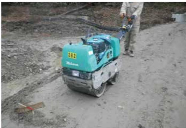
本施工 刃金土敷均し・締固め状況
