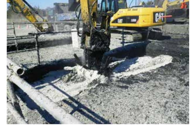
改良状況（セメント系固化材混合）
