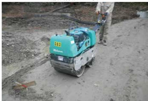
本施工 刃金土敷均し・締固め状況
