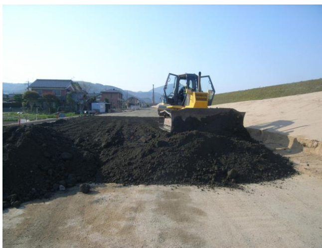
⑤ 改良土の敷均し、締固め
