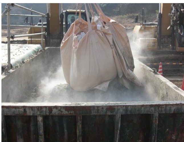
③ セメント等の固化材投入、攪拌
