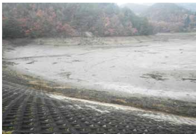
底泥土堆積状況
