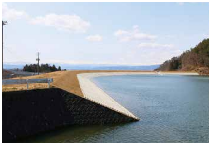
完成（左岸より望む）
