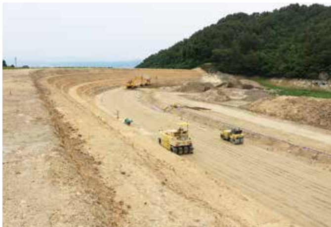
ポンテラン改良土転圧状況
